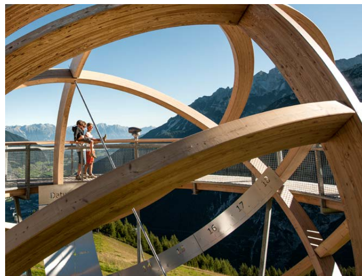
Meridiana percorribile a piedi alla stazione a monte dell'Elferlifte
